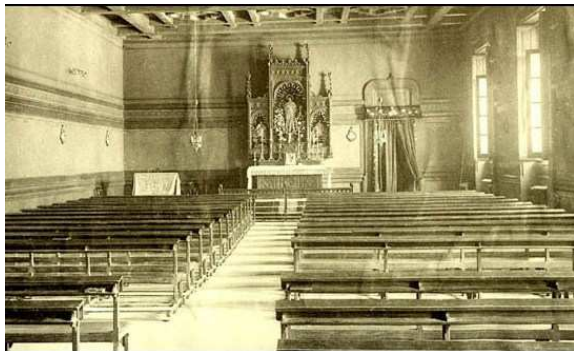
Capilla de las congregaciones antes del incendio
